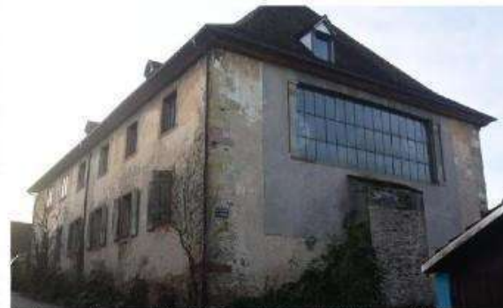
Les travaux soutenus par la Fondation du patrimoine : la réfection complète des murs extérieurs avec enduit à la chaux et badigeon, puis la restauration des menuiseries, portes, volets et colonnes en bois, ainsi que la reprise du sol pavé de la cour. Photo Guy Gredler
