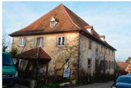
Un appel à dons et à mécénat a été lancé pour la restauration des façades de l'ancienne synagogue. Photo Guy Greder
